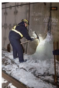
結氷除去作業の様子
