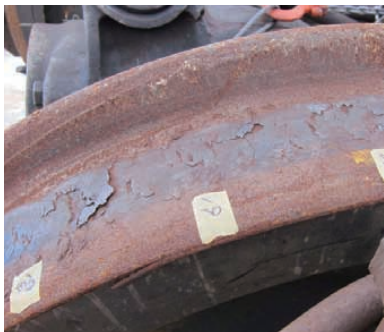
剥離が広がる車輪踏面
