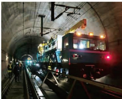
青函トンネルのトロリ線張り替え工事
