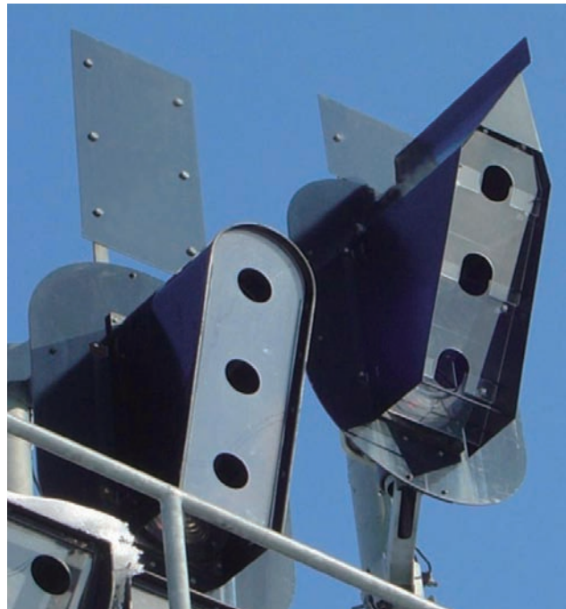
左が従来型防雪フード、右が段差式防雪フード
