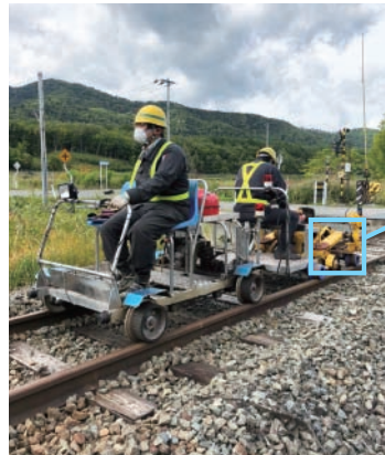
レール研磨作業の様子 (右：レール研磨部)。
