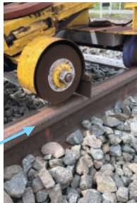
レール研磨作業の様子 (右：レール研磨部)。
