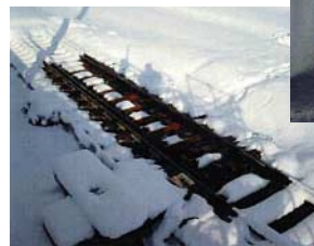
ポイントに堆積する雪や氷塊を効果的に融雪する「ポイントパネルヒーター」
