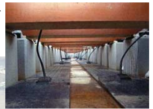
「ポイント融雪ピット式」は、JR北海道が独自に開発した設備で特許も取得
