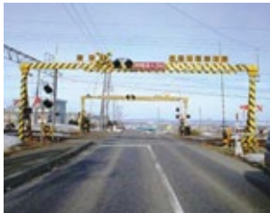
遠くからでもよくわかるオーバーハング型警報装置が設置された踏切
