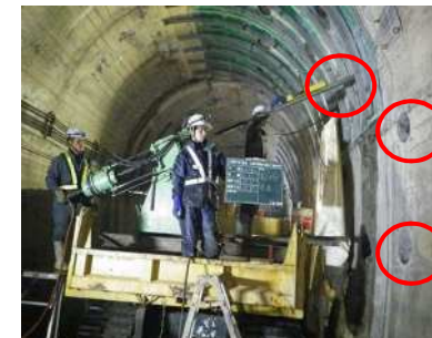
(ロックボルト施工状況)
