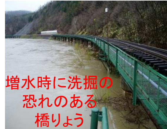
(例: 宗谷線 糠南・雄信内間 問平陸橋)
