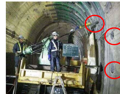
(ロックボルト施工状況)
