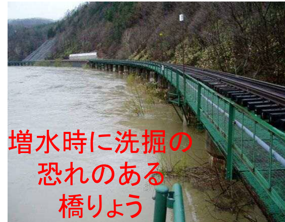
(例:宗谷線 糠南・雄信内間 問平陸橋)
