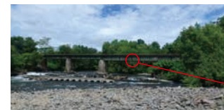
上新府川橋梁(智北・南美深間) 1911(明治44)年完成
