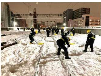
計画運休による集中的な除雪作業
