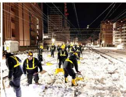
計画運休による集中的な除雪作業
