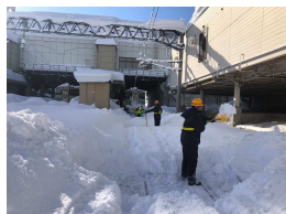
北広島駅除雪作業
