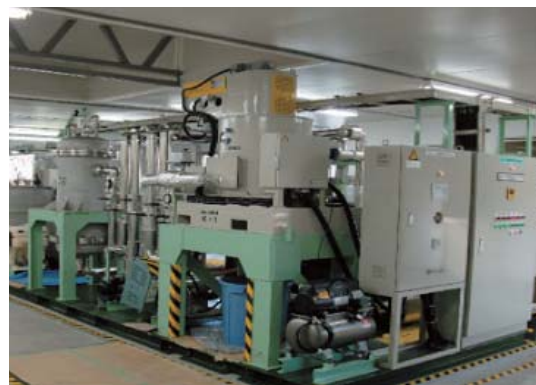
ワックス剥離廃液処理装置
