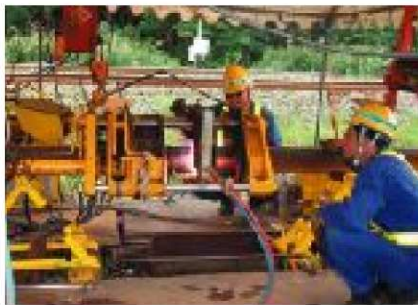
ロングレール製造に用いるガス圧接
