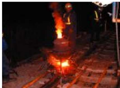
ロングレールの本線レールへの接続に用いるゴールドサミット溶接
