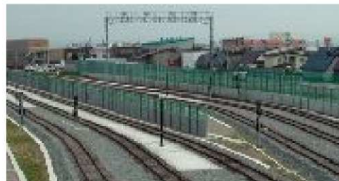
旭川運転所に設置した防音壁
