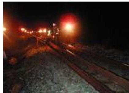
ロングレールの本線への移設作業
