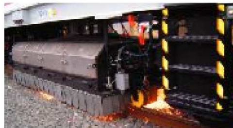
レール削正の状況
