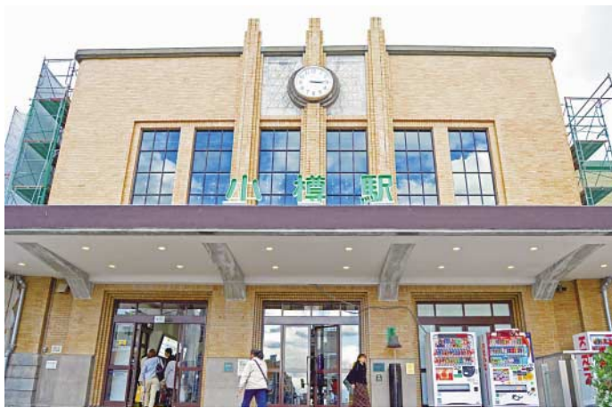
改装工事前の小樽駅本屋。間もなくレトロ調の建物に復元される
