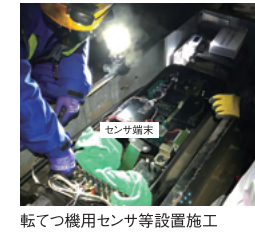
転つ機能センサ等設置施工
