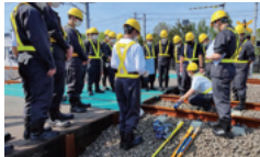
実習線設備を使用したレール計測実習
