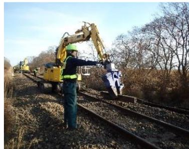
鉄道施設を維持するために11月6日～10日、苫小牧駅～鶴川駅間で日中時間帯の一部列車を運休し、線路集中メンテナンスを実施しました。約1,800本の木製マクラギを交換して線路の状態を改善しました。
